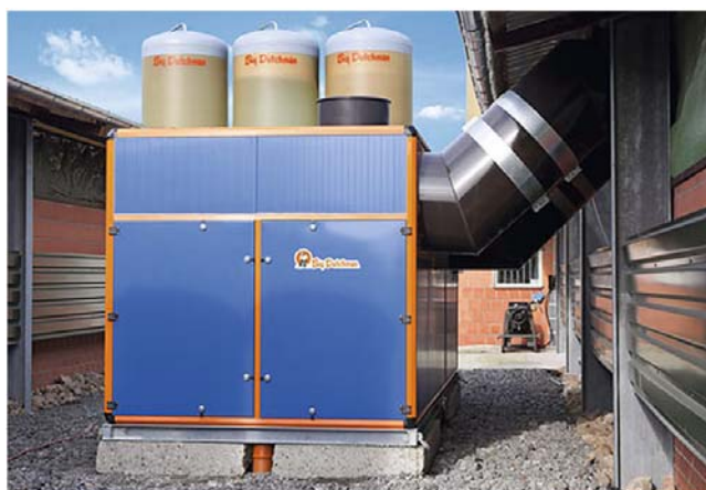
รูปที่ 2 สำหรับประเทศในแถบหนาวมีการเสนอเครื่องแลกเปลี่ยนความร้อน เพื่อลดต้นทุนการให้ความร้อน และลดฝุ่นละอองในโรงเรือน 3
