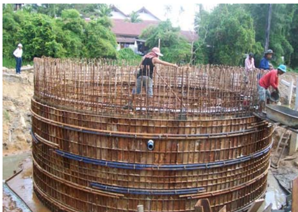
รูปที่ 3 การก่อสร้างบ่อบำบัดน้ำเสีย 4
