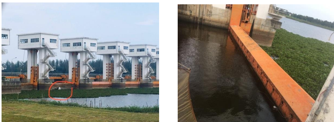
รูปที่ 4.9 รอยรั่วที่บานประตูระบายน้ำอุทกวิภาชประสิทธิ์
