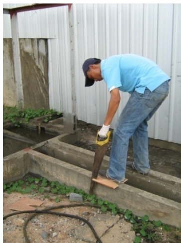
การตัดแผ่นไม้อัดตามการออกแบบฝายวัดน้ำ
