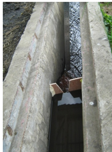
การติดตั้งฝายวัดน้ำชนิดรูปตัววี
