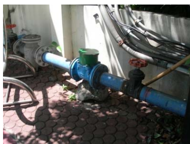
รูปที่ ๓.๕ ตัวอย่างการติดตั้งมิเตอร์น้ำเฉพาะของแหล่งกำเนิดมลพิษ
