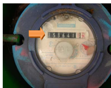
รูปที่ ๓.๕ ตัวอย่างการติดตั้งมิเตอร์น้ำเฉพาะของแหล่งกำเนิดมลพิษ
