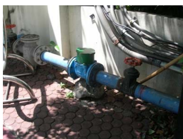
รูปที่ ๓.๕ ตัวอย่างการติดตั้งมิเตอร์น้ำเฉพาะของแหล่งกำเนิดมลพิษ
