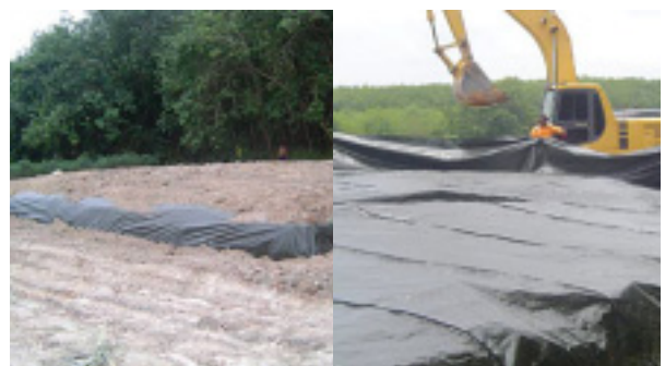
การปิดคลุมหลุมฝังกลบชั่วคราวด้วยแผ่นพลาสติก
