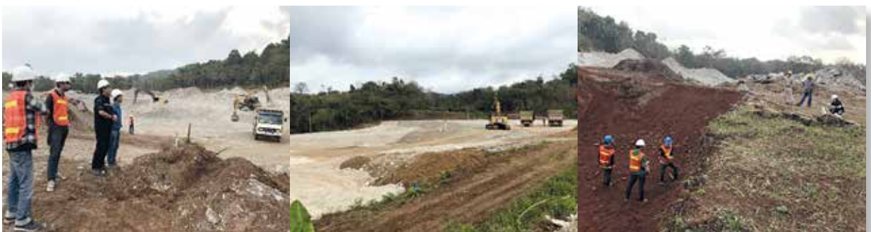
การปรับสภาพพื้นที่บริเวณหลุมฝังกลบแบบปลอดภัยและบริเวณโรงแต่งแร่
