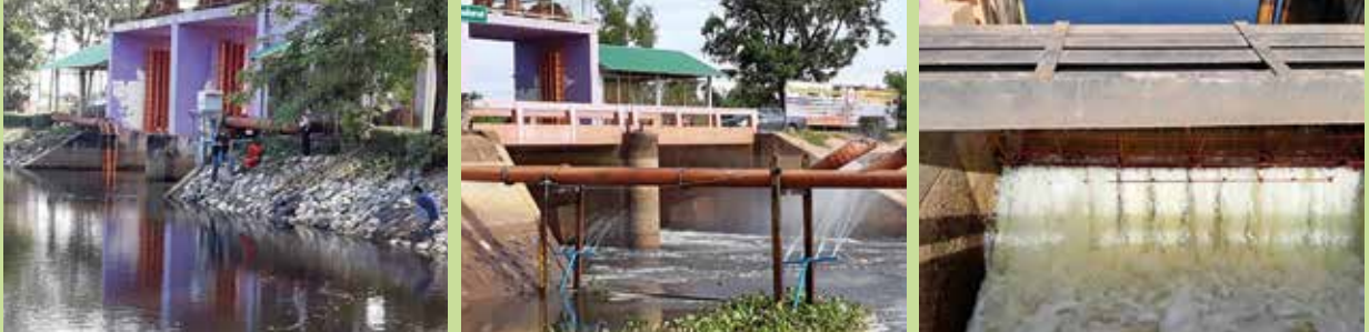
ประตูระบายน้ำคลองสารภี ตำบลวัดโบสถ์ อำเภอเมือง จังหวัดปราจีนบุรี
