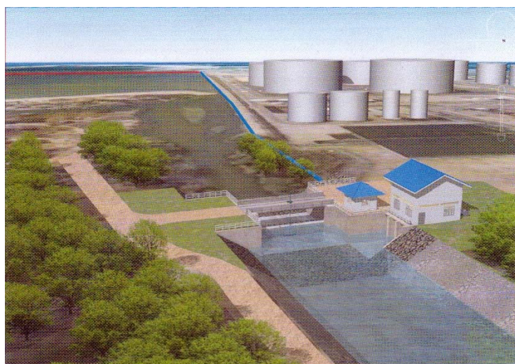
รูปที่ 11 รูปแบบการก่อสร้างฝายน้ำล้นดักตะกอนเพื่อป้องกันไม่ให้ตะกอนใหม่่ออกสู่อ่าวประดู่และนำน้ำกลับมาใช้ประโยชน์ (ภาพจากรายงานฉบับสมบูรณ์ โครงการศึกษาและทบทวนรายงานการวิเคราะห์ผลกระทบสิ่งแวดล้อมและมาตรการที่เกี่ยวข้องโครงการท่าเรืออุตสาหกรรมมาบตาพุด จังหวัดระยอง โดยการนิคมอุตสาหกรรมแห่งประเทศไทย)
