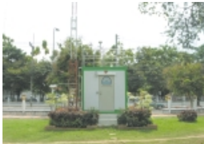
สถานีตรวจวัดคุณภาพอากาศแบบอัตโนมัติ
