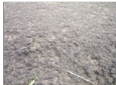
รูปที่ 40 ผิวทางแบบ สโตนมาสติกแอสฟัลต์
