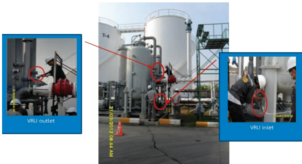
ภาพการเก็บตัวอย่างไอระเหยน้ำมันเบนซินก่อนและหลังเข้าระบบ VRU ด้วย Tedlar bag :Method 18
