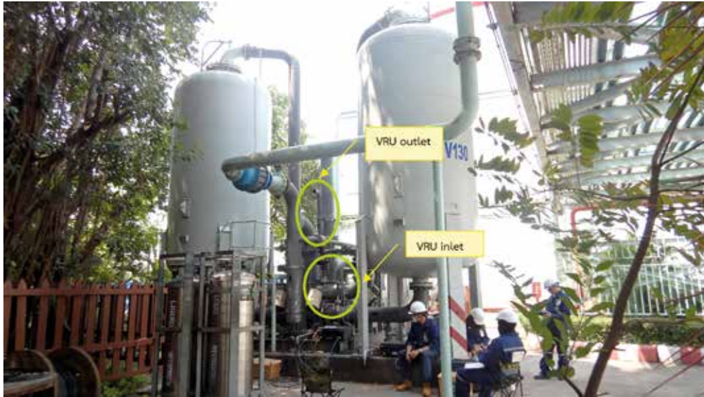
ระบบควบคุมไอระเหยน้ำมันเบนซิน (Vapor Recovery Unit) แบบ Carbon Adsorption
