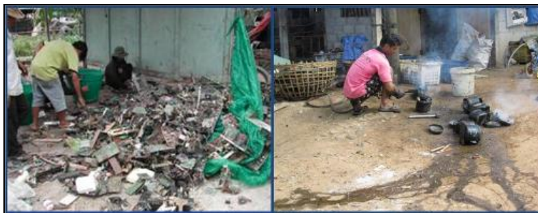
รูปที่ 3.4 การถอดแยกชิ้นส่วนและสกัดโลหะมีค่าจากซากผลิตภัณฑ์ฯ ด้วยวิธีที่ไม่ถูกต้องตามหลักวิชาการ และไม่มีอุปกรณ์ป้องกันอันตรายส่วนบุคคล
