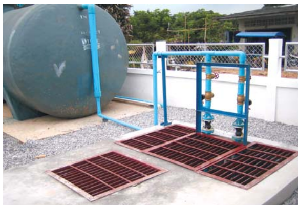
ระบบบำบัดน้ำเสียชุมชนขนาดเล็กในคลองลำปาและคลองคู่ตะเภา
