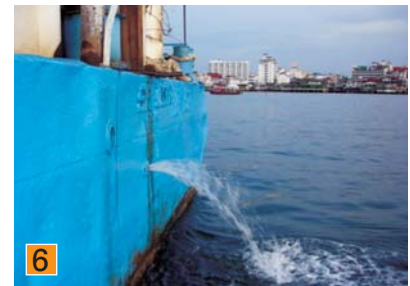
5 - 6 ระบบบำบัดน้ำเสียบนเรือ และท่อ ระบายน้ำหล่อเย็น
