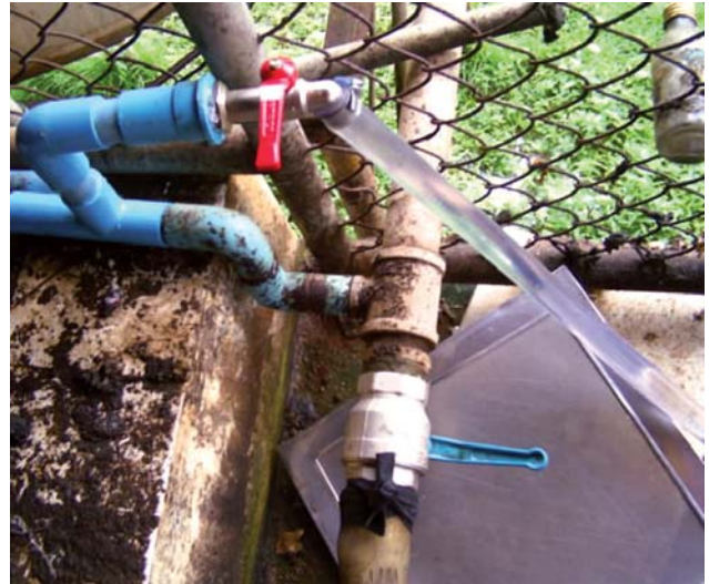
ติดตั้งก๊อกน้ำใหม่แทนของเดิมที่ชำรุด เพื่อป้องกันการรั่วซึมของน้ำ
