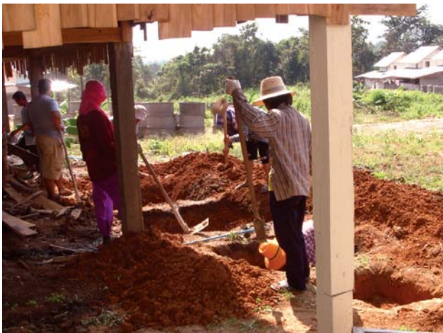
การก่อสร้างระบบบำบัดน้ำเสียในพื้นที่นิคมสร้างตนเองลำน้ำน่าน
