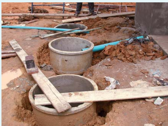
การสร้างระบบบำบัดน้ำเสียสำหรับบ้านเรือนในพื้นที่ประสบอุทกภัย
