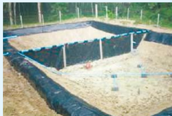
บ่อหมักที่แบ่งออกเป็นสองผลิตภัณฑ์และส่วนผลิตไบโอแก๊ส
