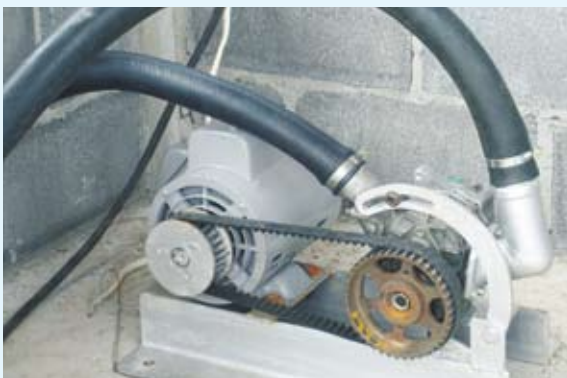
ชุดอุปกรณ์เพิ่มแรงดัน
