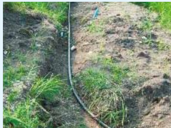
ท่อหลักที่ใช้ในการส่งจ่ายก๊าซชีวภาพ
