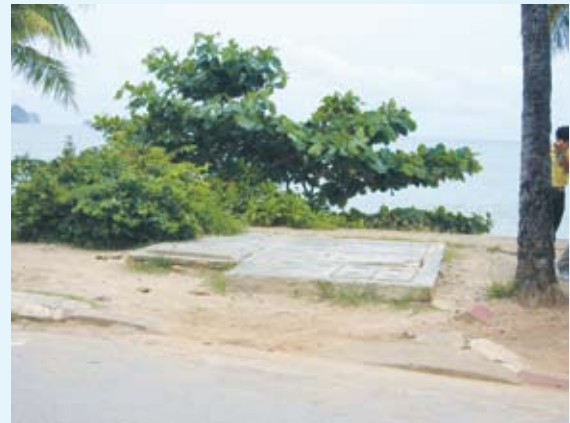
อาคารผันน้ำเสีย (CSO)
