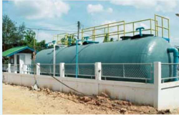
ระบบบำบัดน้ำเสียรวมขนาดเล็ก เทศบาลเมืองสเคา
