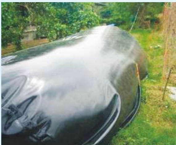
ระบบก๊าซชีวภาพสำรองแบบถุงพลาสติกพีวีซี
