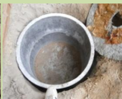
ปอดักขยะและปอดักไขมันที่กำลังก่อสร้าง
