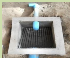
ปอดักขยะและปอดักไขมันที่กำลังก่อสร้าง
