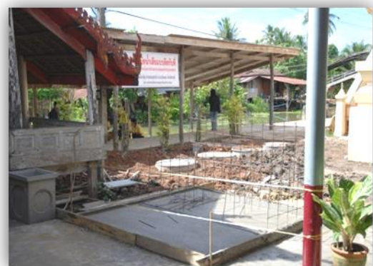
รูปแสดงการจัดสร้างระบบบำบัดน้ำเสียนาร่อง ณ วัดแจ้งเจริญ
