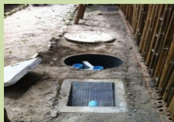
ปอดักขยะและปอดักไขมันที่ก่อสร้างแล้วเสร็จ
