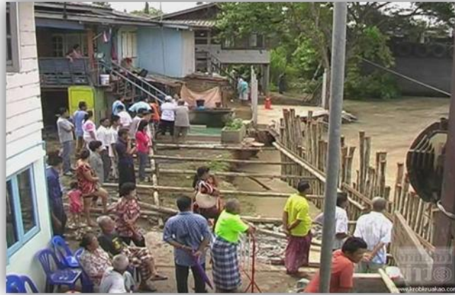
การก่อสร้างเขื่อนป้องกันกระแสน้ำกัดเซาะชั่วคราว
