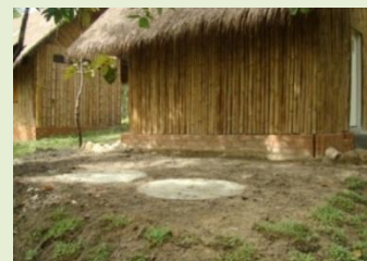
ระบบอดกรองไร้อากาศที่ก่อสร้างแล้วเสร็จ
