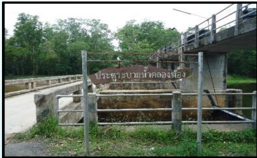
รูปที่ 1 ประตูระบายน้ำคลองช้อง
