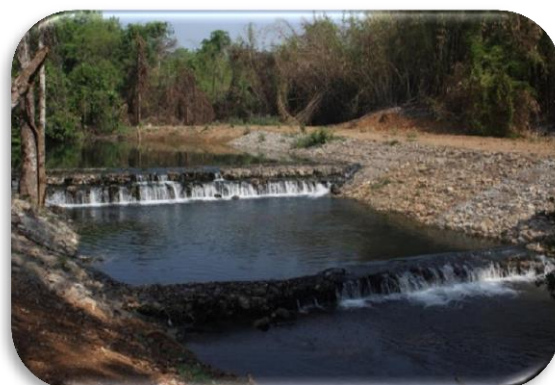
รูปที่ 4 ฝายดักตะกอนหลังก่อสร้างเสร็จ
