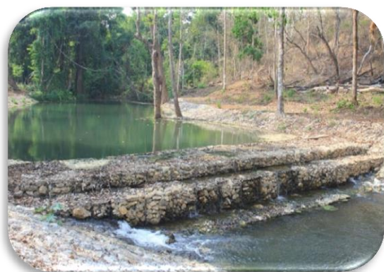
รูปที่ 4 ฝายดักตะกอนหลังก่อสร้างเสร็จ
