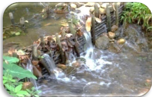
รูปที่ 1 การอบรมและปฏิบัติการก่อสร้างฝายชะลอน้ำ
