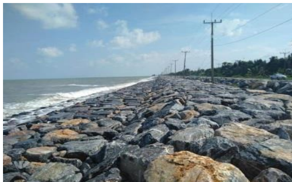
รูปที่ 3 การก่อสร้างกำแพงหินทิ้งป้องกันการกัดเซาะชายฝั่งในพื้นที่ลุ่มน้ำปากพนัง
