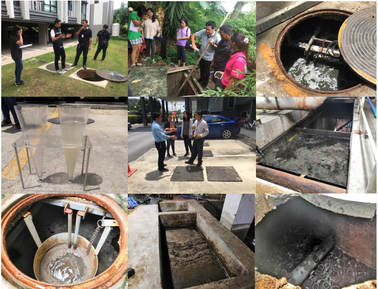
รูปที่ 1 การลงพื้นที่ให้คำแนะนำด้านเทคนิควิชาการในการปรับปรุงแก้ไขระบบบำบัดน้ำเสียของแหล่งกำเนิดมลพิษ ในพื้นที่คลองแสนแสบ
