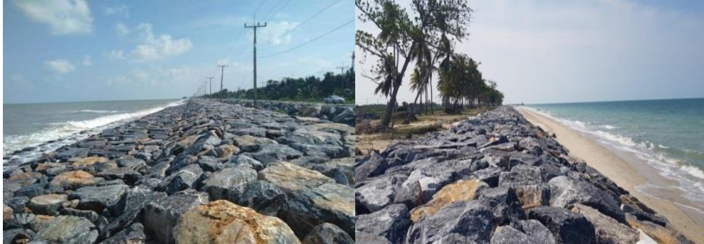
รูปที่ 3 การก่อสร้างกำแพงหินทิ้งป้องกันการกัดเซาะชายฝั่งในพื้นที่ลุ่มน้ำปากพนัง
