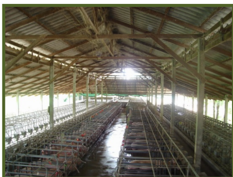
โรงเรือนหลังคาสูง เพื่อการระบายอากาศที่ดี
