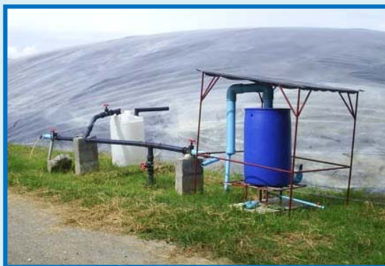
ระบบกำจัดกลิ่นแบบชีวภาพชนิดไบโอฟิลเตอร์
