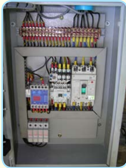
รูปแสดงผังวงจรภายในตู้ควบคุมและตัว Over load
