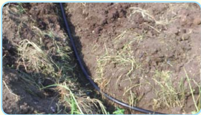
รูปแสดงท่อหลัก (HDPE) ที่ใช้ในการส่งจ่ายก๊าซชีวภาพ
