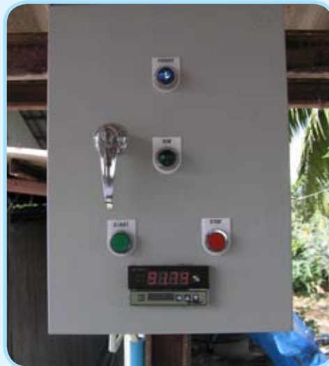
รูปหน้าจอแสดงปริมาณออกซิเจนในก๊าซบนตู้ควบคุมการทำงาน
