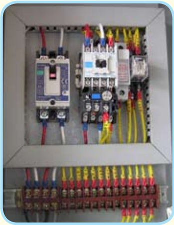
รูปแสดงผังวงจรมายใน ตู้ควบคุมและตัว Over load
