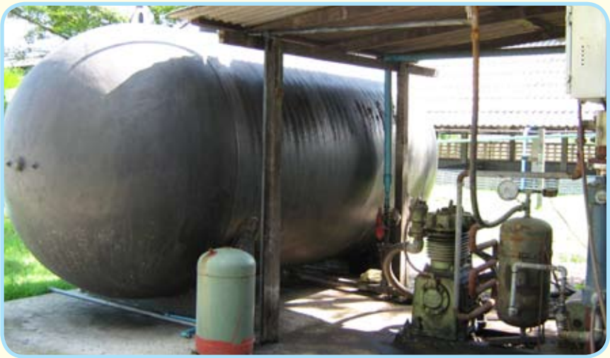
รูปแสดงถังเก็บสำรองก๊าซชีวภาพไว้ใช้ภายในฟาร์มสุกร
