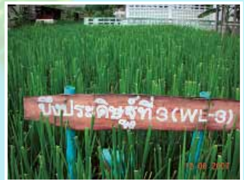
การบำบัดน้ำเสียระบบบึงประดิษฐ์โดยใช้ต้นรูปฤาษี
