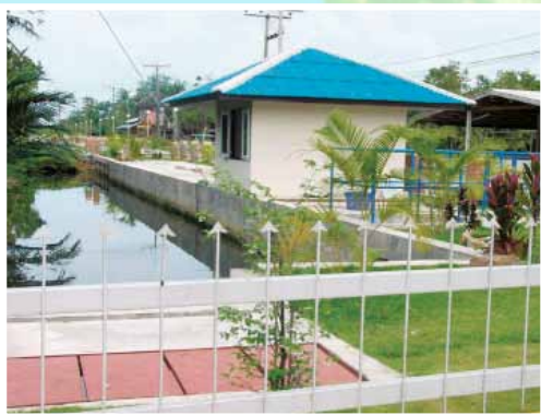
ระบบบำบัดน้ำเสียเฉพาะจุด แบบป่องกรองไร้อากาศตามด้วยบึงประดิษฐ์
