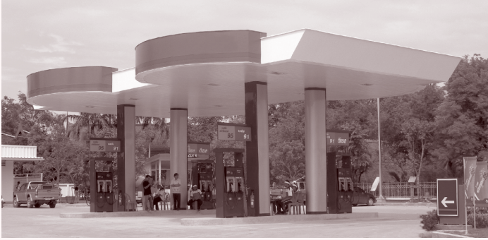
รูปที่ 1.1 สถานีบริการน้ำมันเชื้อเพลิง
