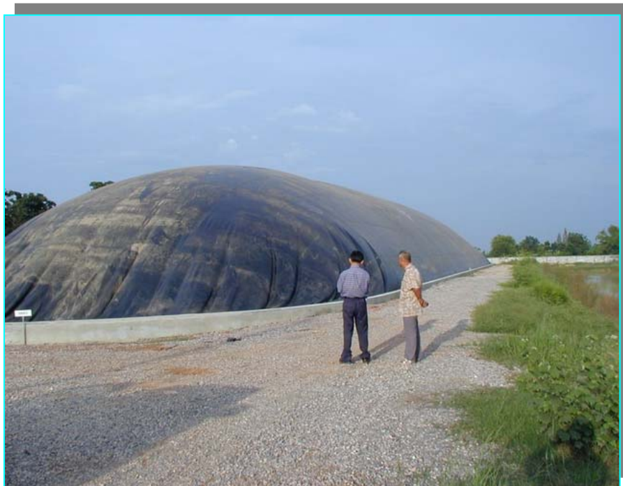
รูปที่ 3.8 ระบบบ่อหมักไม่ใช้อากาศแบบปิดฝาในการบำบัดน้ำเสียจากฟาร์มสุกร
