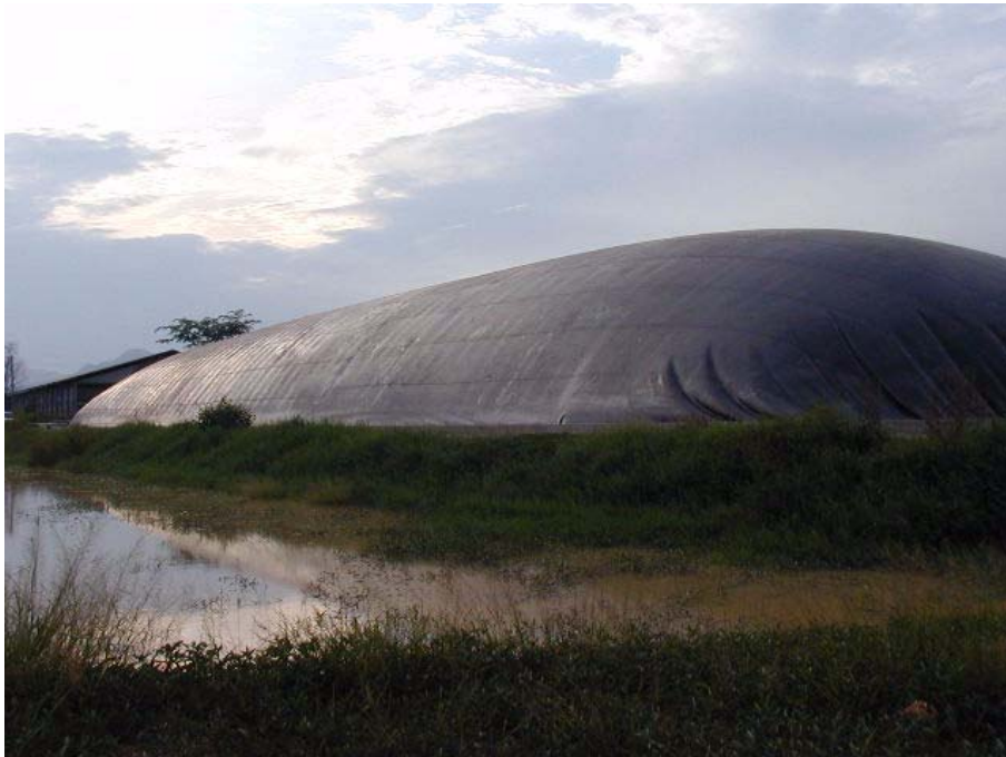
รูปที่ 6.15 ปอหมักไม่ใช้อากาศแบบปิดฝา (ข้อมูลของบริษัท แชน.อี.68 คอนซัลตติ้ง เอ็นจิเนียรส์ จำกัด)
