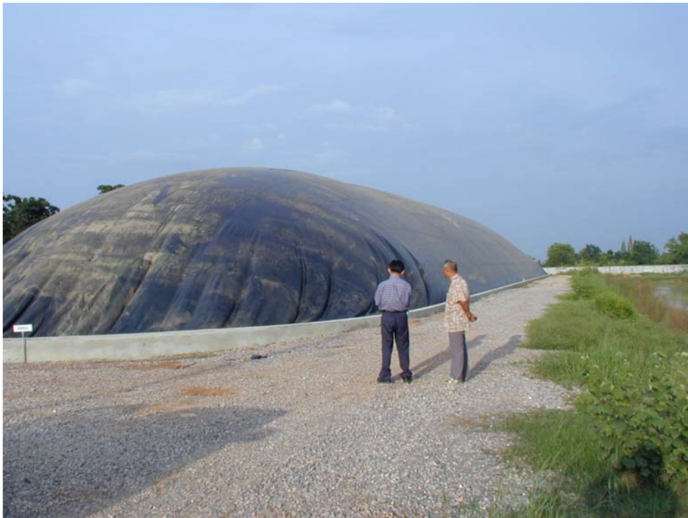
รูปที่ 7.2 การรวบรวมก๊าซแบบคลุมด้วยบอลลูน (ฟาร์มหมูใน จ.ราชบุรี)
