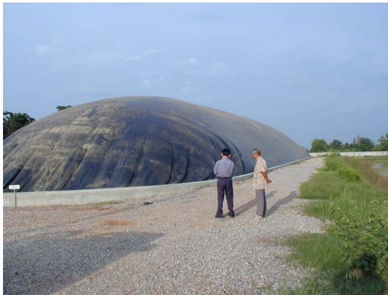
รูปที่ 3.2 บ่อหมักไม่ใช้ออกซิเจนที่ครอบด้วยแผ่นยางพียูหนา 1 มม. (ฟาร์มหมูใน จ.ราชบุรี)
