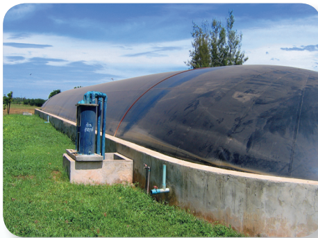
ระบบบำบัดน้ำเสียฟาร์มสุกร
