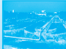
โรงบำบัดน้ำเสียแบบคลองงานเวียน (OD) ระยะที่ 2
