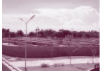
บ่อเติมอากาศแบบคลองวงเวียน
