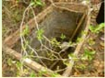
ในช่วงหน้าแล้งหลุมตักตะกอนจะแห้ง สามารถตักหรือขุดตะกอนออกไปทำปุ๋ยได้
