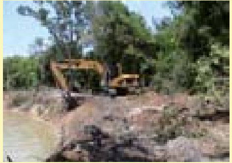
การขุดลอกตะกอนของแม่น้ำประแส
