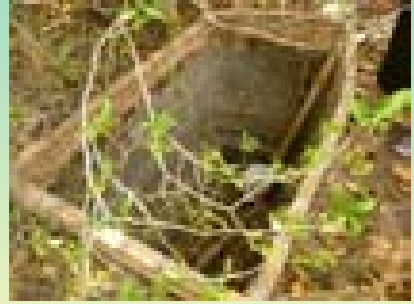
ในช่วงหน้าแล้งหลุมดักตะกอนจะแห้ง สามารถดักหรือขุดตะกอนออกไปทำปุ๋ยได้
