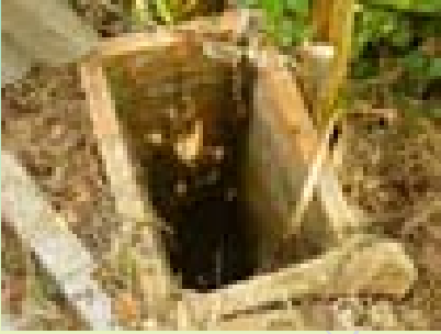
หลุมดักตะกอนก่อด้วยอิฐมอญ
