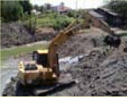
การขุดลอกตะกอนของแม่น้ำประแส
