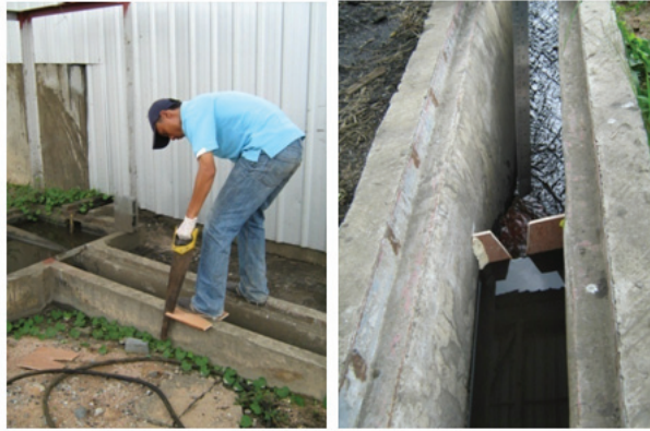
การตัดแผ่นไม้อัดตามการออกแบบฝายวัดน้ำ และการติดตั้งฝายวัดน้ำชนิดรูปตัววี
