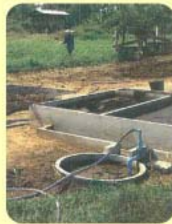
การตักตะกอนและน้ำโดยใช้ปั๊มจุ่มสูบ
