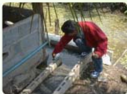
รางรวบรวมน้ำเสียเข้าสู่ระบบบำบัดน้ำเสีย
