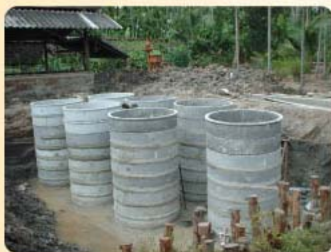
วงปลอกคอนกรีตที่นำมาก่อสร้างถังแยกตะกอนหนัก ถังเกราะ และถังกรองไร้อากาศ
