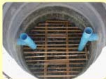
ชั้นกรองใส่ตัวกลางในถังกรองไร้อากาศ
