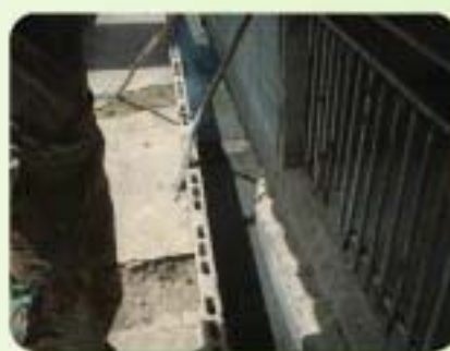
รางรวบรวมน้ำเสียเข้าสู่ระบบบำบัดน้ำเสีย
