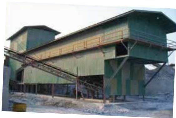
ภาพแสดงการปิดคลุมอาคารโรงโม่บดหรือย่อยหิน
