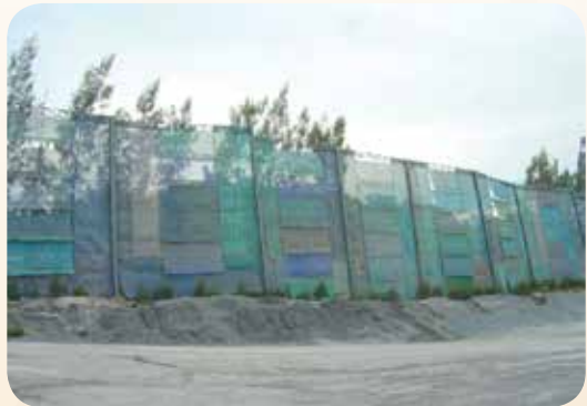
ภาพแสดงแนวตาข่ายและแนวต้นไม้ทรงสูงเพื่อป้องกันฝุ่นละอองจากโรงโม่บดหรือย่อยหิน
