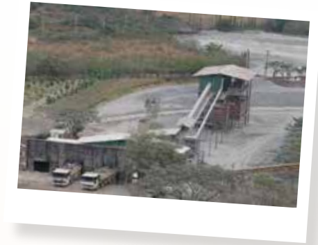
ภาพแสดงการปิดคลุมอาคาร 3 ด้าน บริเวณปากโม้และการปิดคลุมทั้งระบบ
