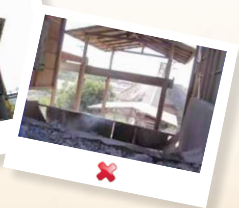
ภาพแสดงการปิดคลุมอาคาร 3 ด้านบริเวณปากโม้ (ภาพซ้าย) และการปิดคลุมไม่ครบ 3 ด้าน (ขวา)
