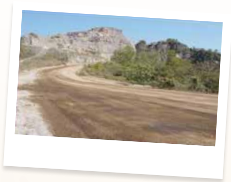
ภาพแสดงการฉีดพ่นกาน้ำตาลบริเวณเส้นทางลำเลียงหินเพื่อป้องกันฝุ่นละอองฟุ้งกระจาย
