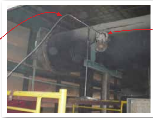
รูปที่ 3-5 แสดงการซັกตัวอย่างกลิ่นจากปล่องระบายอากาศเสีย
