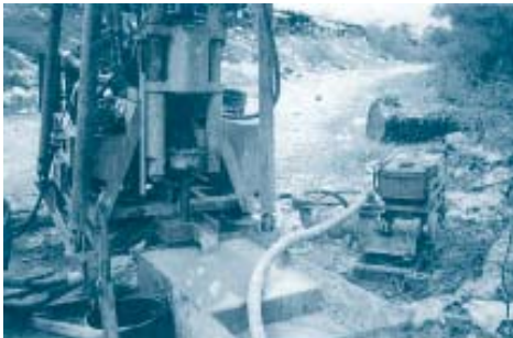
การเจาะดินด้วยวิธี Wash Boring
