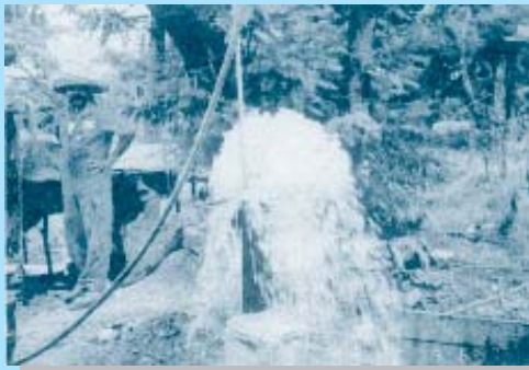
การพัฒนาบ่อโดยวิธี Airlifting ภายหลังการติดตั้งแล้วเสร็จ
