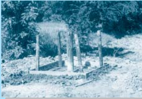
ติดตั้งฐานคอนกรีตและเสาป้องกันรอบบ่อตรวจสอบ
