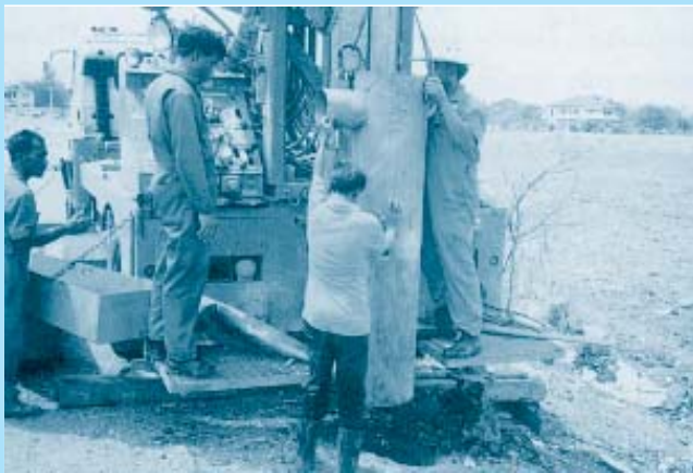
การติดตั้งท่อป้องกันเพื่อป้องกันหลุมเจาะพัง
