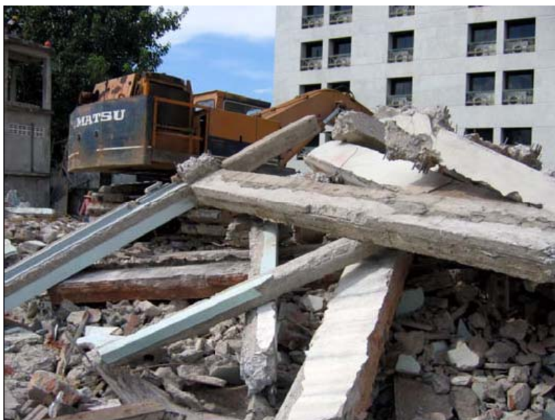
รูปที่ 7 ของเสียจากการรื้อถอนส่วนใหญ่ประกอบด้วยแผ่นพื้นคอนกรีตเสริมเหล็ก
