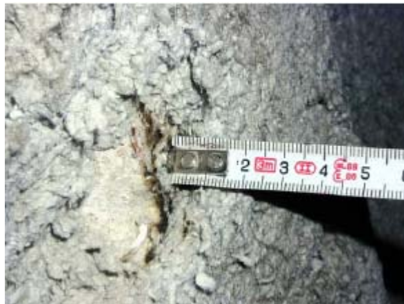
รูปที่ 23 ฉนวนกันความร้อนของท่อไอน้ำที่มีแอสเบสตอสเป็นองค์ประกอบ
