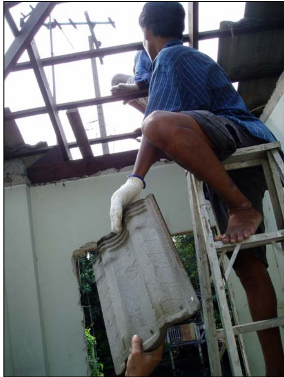
รูปที่ 7.4 การรื้อหลังคาโดยใช้แรงงานคนเพื่อนำกระเบื้องไปใช้ซ้ำ
