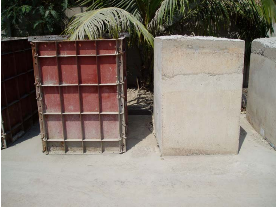
รูปที่ 6.4 แบบหล่อคอนกรีตผสมเสร็จที่ถูกล้างกลับมายังบริษัท
