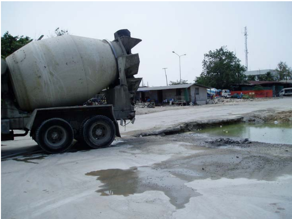
รูปที่ 6.3 ปอรองรับเศษคอนกรีตผสมเสร็จและน้ำล้างทำความสะอาดรถ
