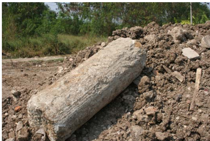
รูปที่ 2.10 ของเสียผสมจากการก่อสร้างและรื้อถอนร่วมกับคอนกรีตขนาดใหญ่ที่ไม่ได้ย่อยขนาด (สถานที่กองเก็บที่ 3)
