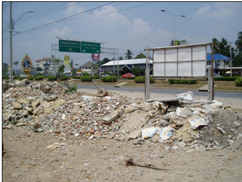
รูปที่ 7.11 การจัดเก็บเศษวัสดุจากการรื้อถอนในบริเวณที่เก็บกองชั่วคราว
