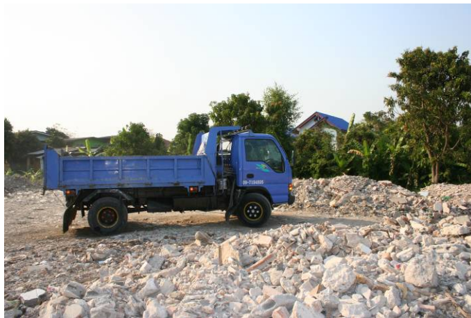
รูปที่ 2.37 การนำเอาของเสียจากการก่อสร้างและรื้อถอนไปใช้ในการถมที่
