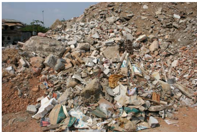
รูปที่ 2.8 ขยะและวัสดุอันตรายปนกับของเสียผสมจากการก่อสร้างและรื้อถอน (สถานที่กองเก็บที่ 2)
