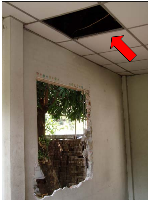
รูปที่ 7.6 การรื้อฝ้าเพดานโดยใช้แรงงานคน
