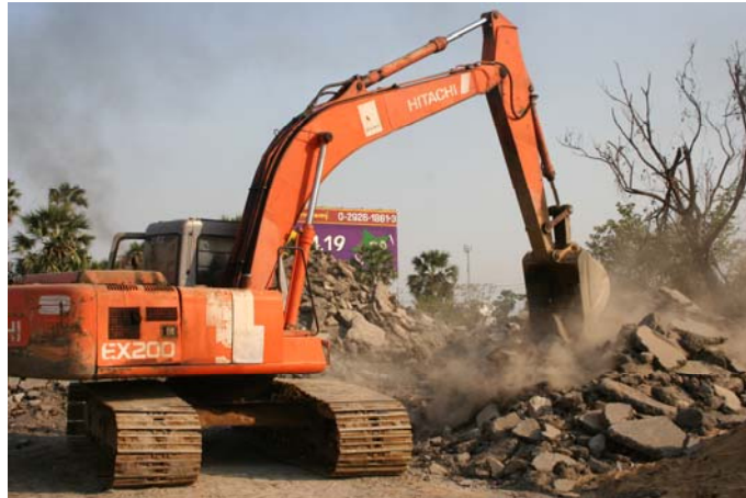
รูปที่ 2.18 การบดย่อยขนาดชนิดของเสี่ยประเภทแอสฟัลต์ (สถานที่กองเก็บที่ 5)
