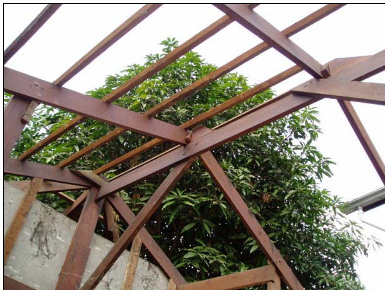
รูปที่ 7.5 การรื้อโครงหลังคาโดยใช้แรงงานคนเพื่อนำไม้หรือเหล็กไปใช้ซ้ำ
