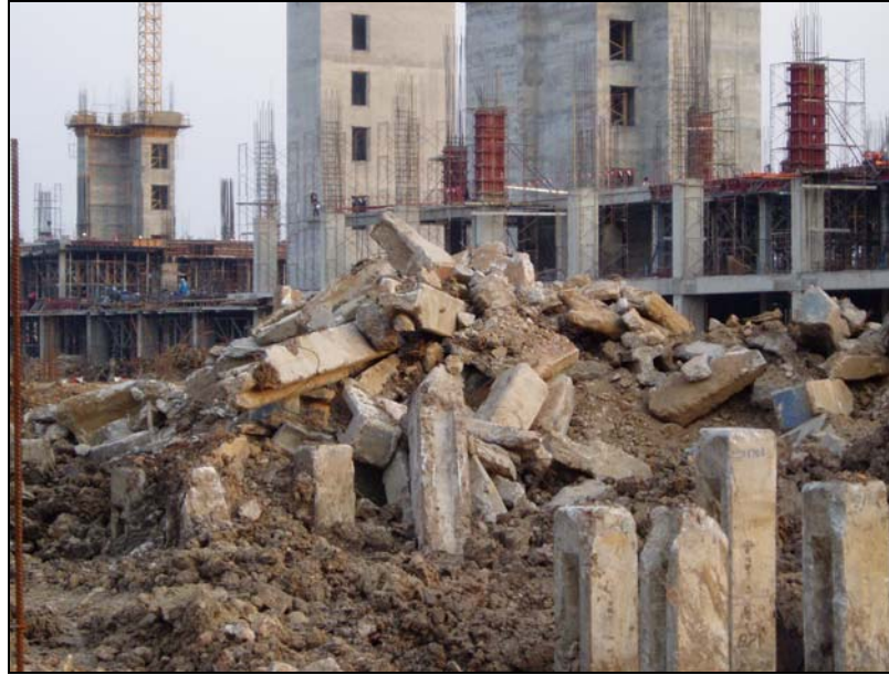
รูปที่ 5.3 เศษคอนกรีตจากเสาเข็ม
