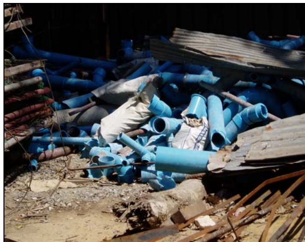
รูปที่ 5.6 พื้นที่จัดเก็บเศษวัสดุในสถานที่ก่อสร้าง
