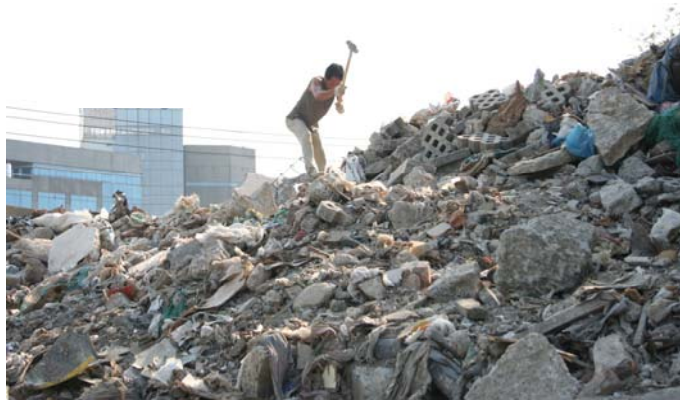
รูปที่ 2.14 การย่อยขนาดคอนกรีตเพื่อนำเหล็กออกโดยใช้แรงคน (สถานที่กองเก็บที่ 4)
