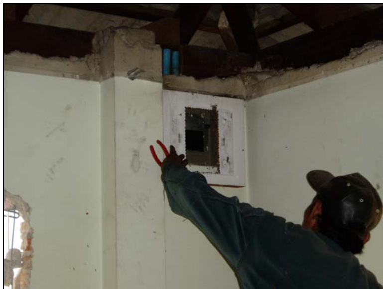
รูปที่ 7.9 การรื้อระบบไฟฟ้าในอาคาร
