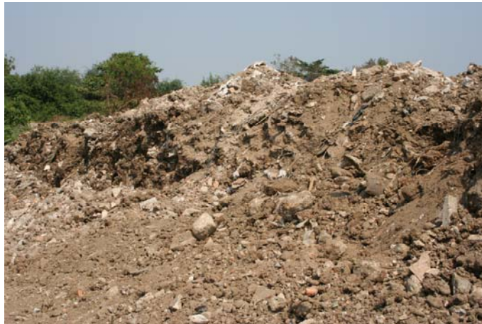
รูปที่ 2.9 ของเสียผสมจากการก่อสร้างและรื้อถอนจากสถานที่กองเก็บที่ 3 โดยที่ ก. คอนกรีตและดินเป็นองค์ประกอบหลัก ข. ขยะปนเปื้อน
