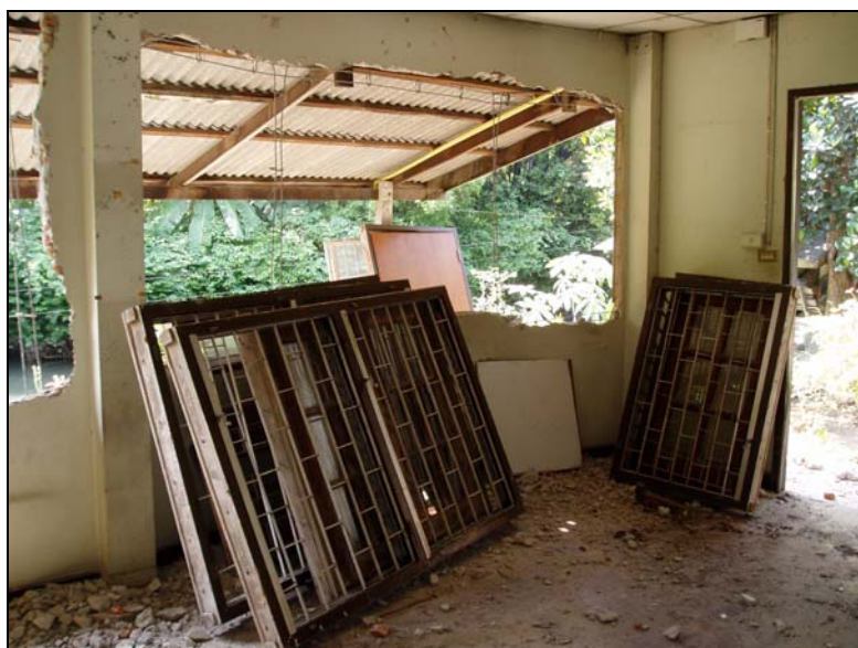
รูปที่ 7.7 วงกบ ประตู หน้าต่าง รื้อถอนโดยใช้แรงงานคนเพื่อแยกส่วนประกอบของวงกบที่เป็นไม้ ออกไปขายเป็นวัสดุก่อสร้าง
