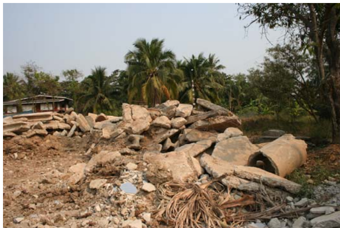
รูปที่ 2.4 ของเสียผสมจากการก่อสร้างและรื้อถอนจากสถานที่กองเก็บที่ 1
