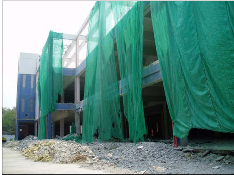
รูปที่ 7.10 ล้อมอาคารด้วยผ้าใบเพื่อป้องกันฝุ่นจากการรื้อถอน
