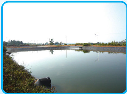
บ่อบำบัดน้ำชะขยะมูลฝอย
