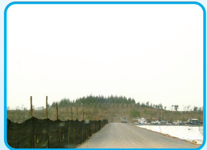
ติดตั้งตาข่ายป้องกันการปลิวและฟุ้งกระจาย
