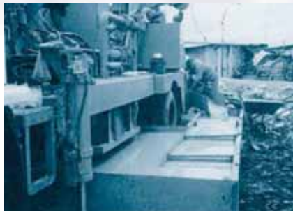
การติดตั้งบ่อตรวจสอบคุณภาพน้ำด้วยวิธี Direct Mud Circulation Rotary
