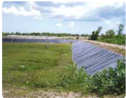
ภาพแสดงลักษณะการฝังกลบบนพื้นที่ (Area Method)
