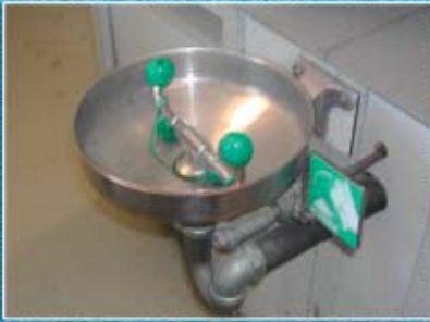
อ่างล้างตาเมื่อเกิดอุบัติเหตุต้อง ติดตั้งไว้ในห้องปฏิบัติการ
