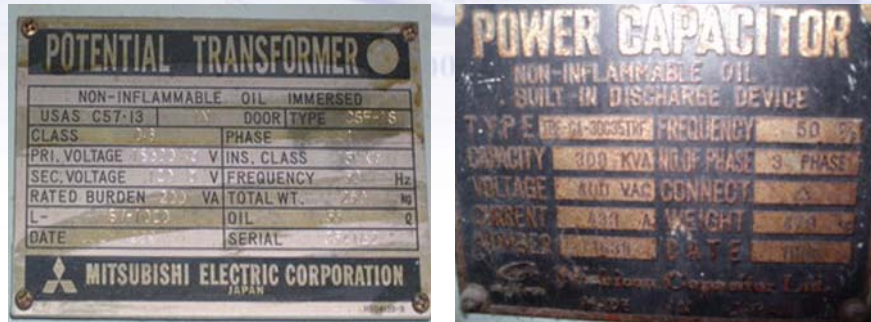
รูปที่ 8 หม้อแปลงไฟฟ้าและตัวเก็บประจุไฟฟ้าพีซีบี
