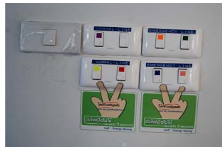
รูปที่ 3-9 : สวิตช์แยกการเปิดปิดเป็นโซน
