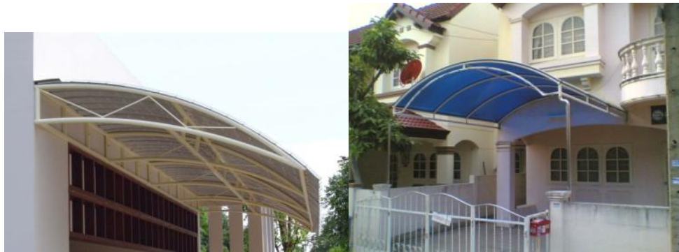
รูปที่ 3-4 : กันสาดเมทัลชีท และกันสาดโพลีคาบอเนต
