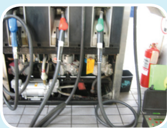
การติดตั้งระบบควบคุมไอระเหยที่หัวจ่ายน้ำมัน ในสถานีบริการน้ำมัน
