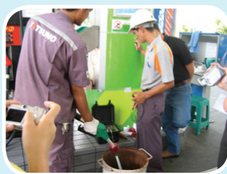
การติดตั้งระบบควบคุมไอระเหยที่หัวจ่ายน้ำมัน ในสถานีบริการน้ำมัน
