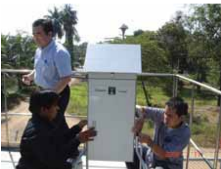
การติดตั้งเครื่องมือ
