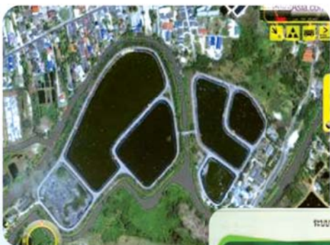
ระบบบำบัดน้ำเสีย เทศบาลนครระยอง
