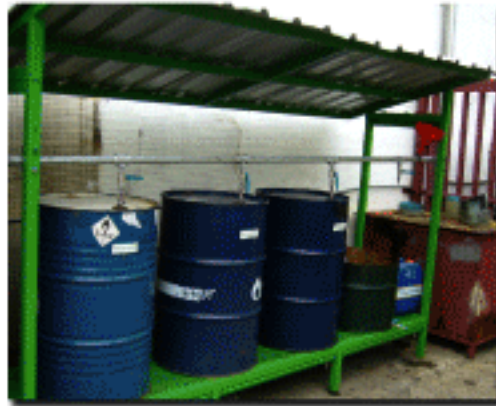
ภาพที่ 4-13: การจัดให้มีอุปกรณ์รองรับพร้อมถังรองน้ำมันที่ใช้แล้ว
