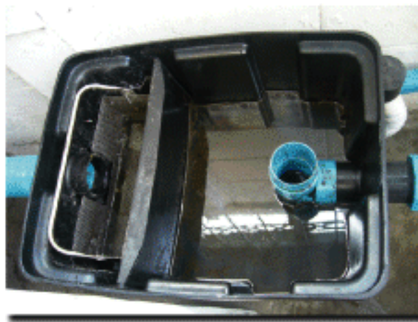
ภาพที่ 4-11: การติดตั้งถังดักไขมันในบริเวณอ่างล้างมือของพนักงาน
