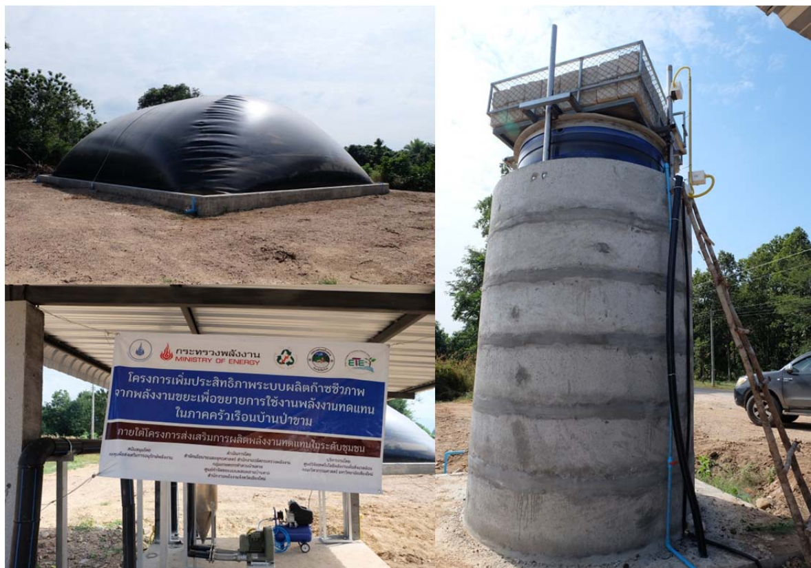
รูปที่ 9 แสดงอุปกรณ์ประกอบโครงการเพิ่มประสิทธิภาพระบบผลิตก๊าซชีวภาพจากพลังงานขยะเพื่อขยายการใช้พลังงานทดแทนในภาคครัวเรือนบ้านป่าขาม
